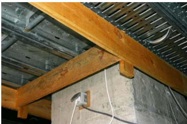
Renforcement du plancher de la coupole Ash Dome
