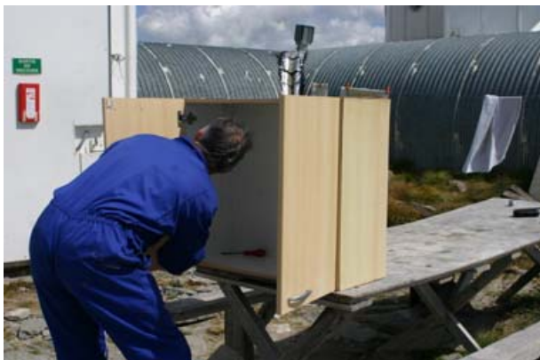
Nettoyage et réparation des placards de la cuisine
