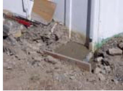
Mortier et bouchage des entrées de gaine
