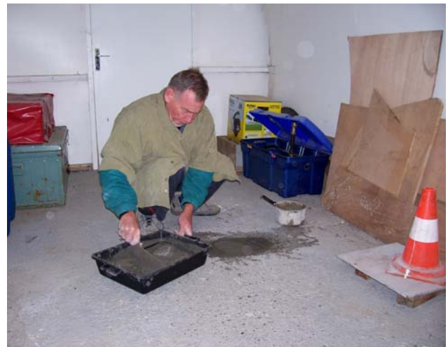
Poursuite des opérations de maintenance
