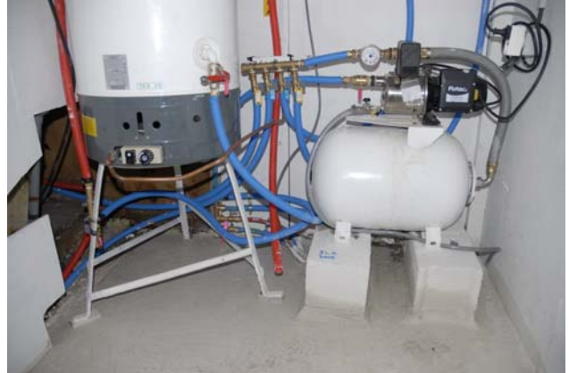
La rénovation du local technique
