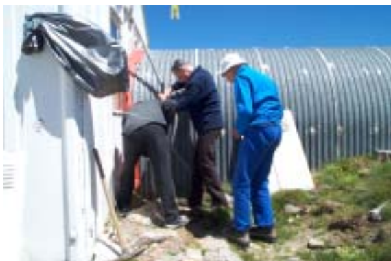
Travaux de plomberie...
